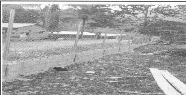
Se observa la terminación del muro perimetral del establecimiento
