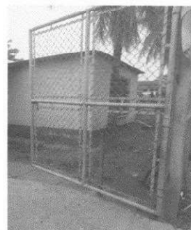
Se observa la instalación del porton principal del establecimiento ya remozado
