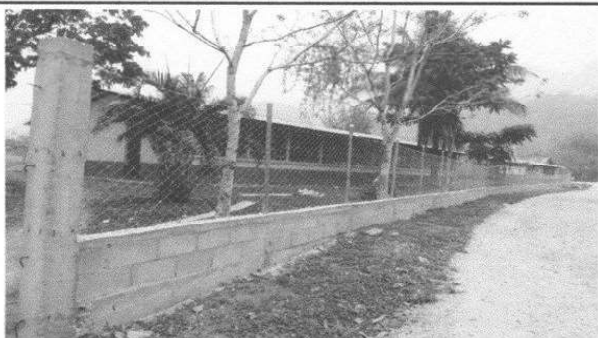
Se observa el muro perimetral del establecimiento ya remozado
